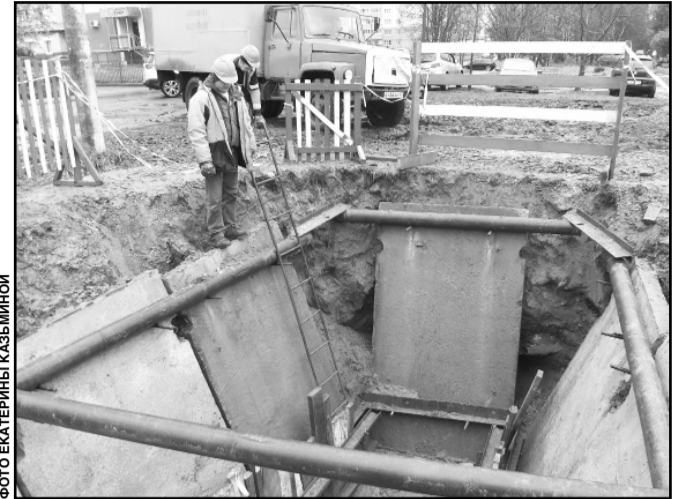
2-3-х дней до полного восстановления и восстановления асфальтового покрытия», — рассказал Станислав Соболев, мастер ВиК МУП «Водоканал» Гатчины.
